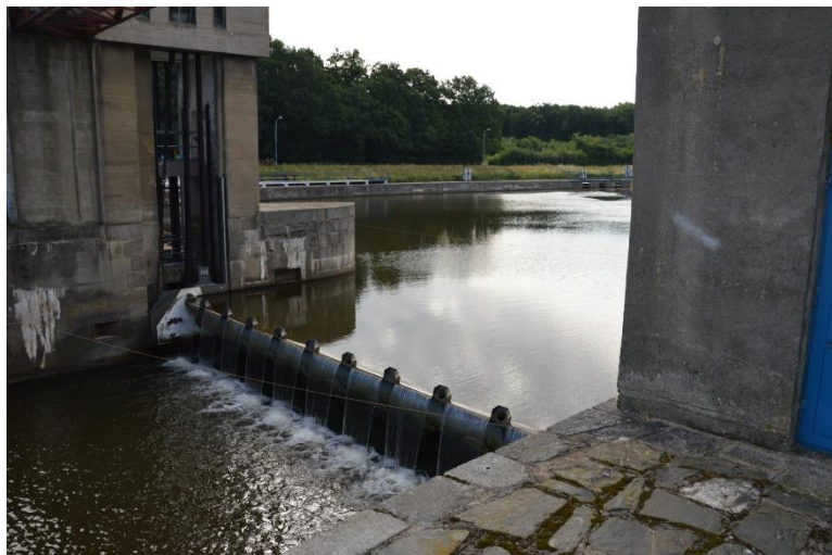
Př. 4 Vzduvací zařízení a názorná ukázka malého spádu 1,9 metru
