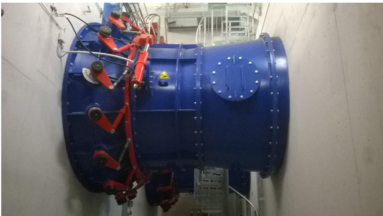
Př. 1 Kaplanova přímoproudá turbína
