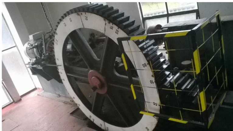
Př. 5 Prvorepublikové zařízení vzduvacího zařízení VD Velký Osek
