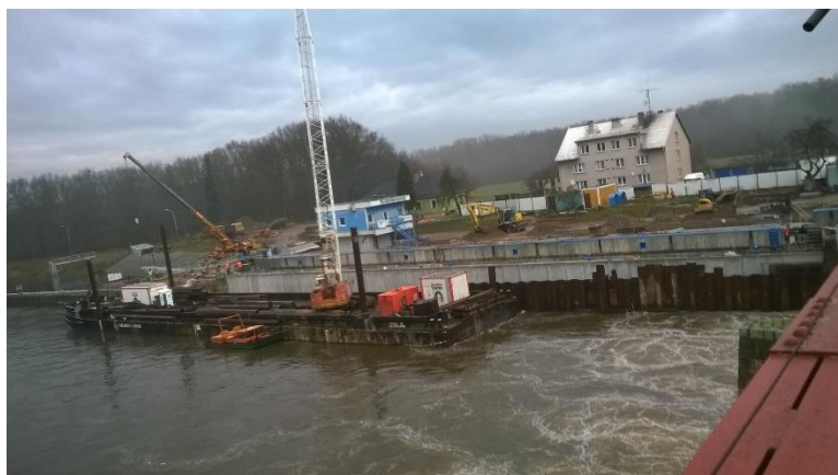
Př. 6 Fotografie dokončovacích prací na modernizaci plavební komory
